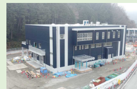
生ごみ等資源化施設
