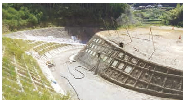
市道新設工事現場 月田地内
