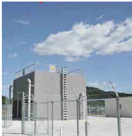
西河内第2浄水場
