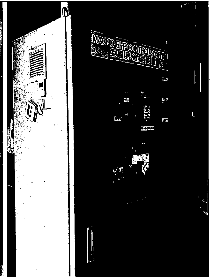
亜臨界処理のコントロールパネル
