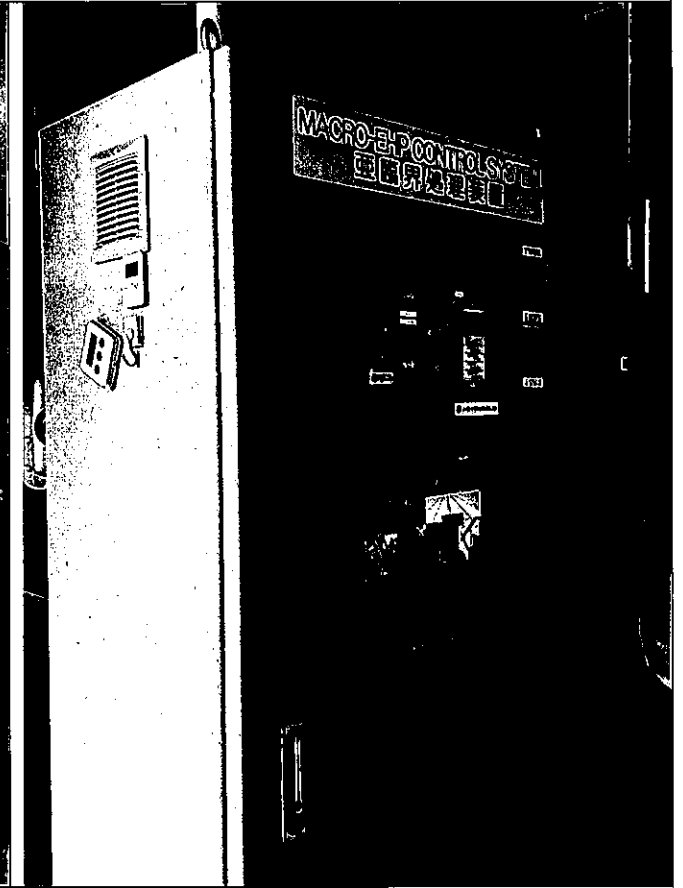
亜臨界処理のコントロールパネル
