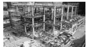
処理管理棟の躯体工事およびメタン発酵槽の据付工事写真(4月末現在)
