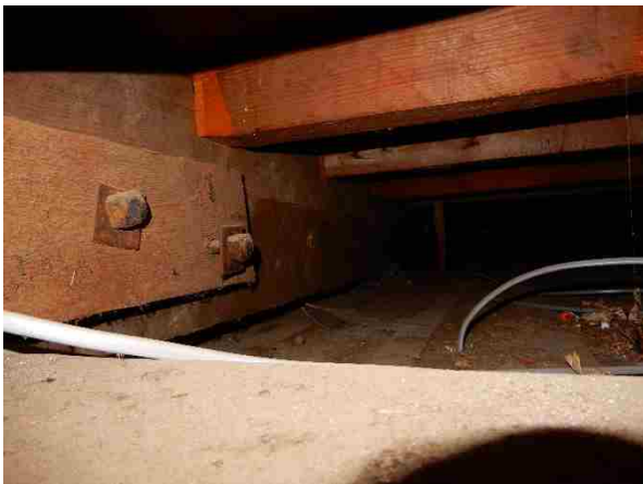
写真 57 一階天井裏(二階床下)の状態
