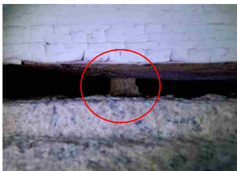
写真 3 鉄格子が失われている。
