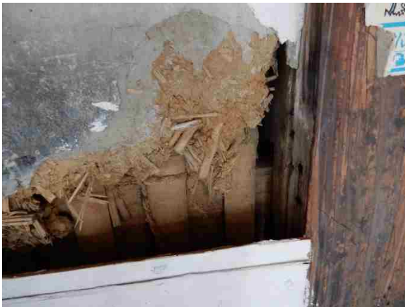
写真 55 現状土壁の仕様 竹小舞縄巻き 荒壁・中塗・灰色漆喰(大津壁風) 漆喰仕上
