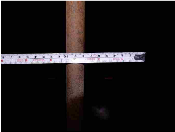
写真26 トラス中央引張り鉄筋 直径24mm
