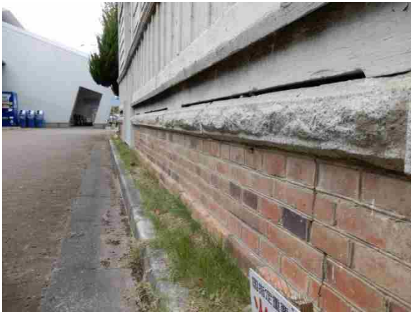
写真 1 基礎詳細 覆輪目地が綺麗に残っている。
