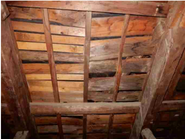
写真22 野地板 数種類ある ルーフィングが見えている
