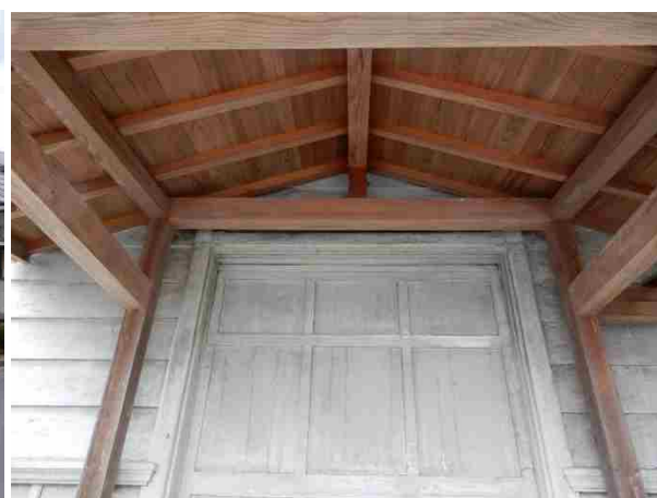
写真 52 屋根が新しくなっている。
