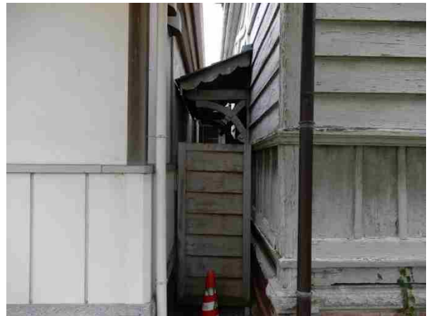
写真 44 西面出入口 塞がれている
