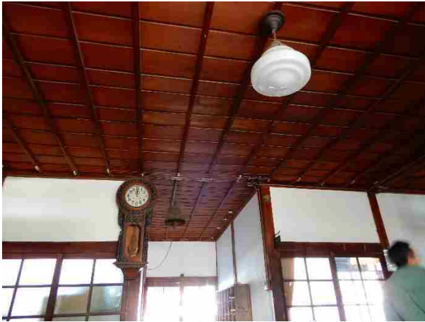
写真 30 玄関ホール 天井
