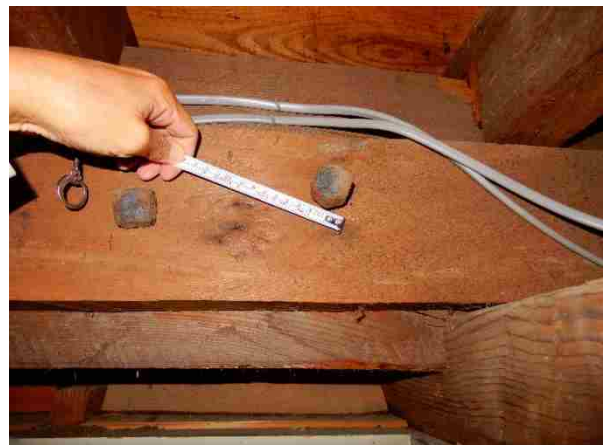
写真 58 四角ボルトと六角ボルトが使われているボルトに緩みがある
