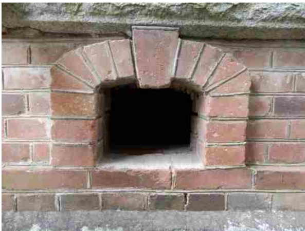
写真 3 鉄格子が失われている。
