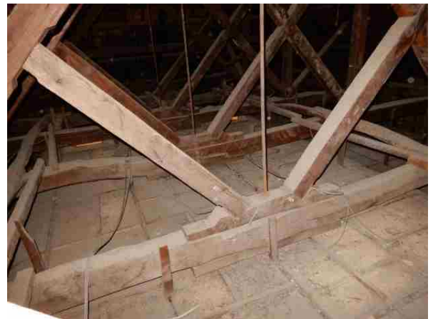
写真25 講堂上トラス下部
