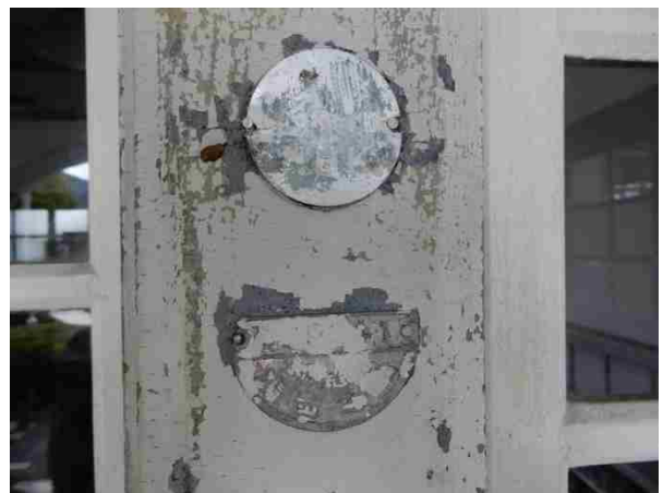
写真9 プレートの下に濃いグレーが残る。
