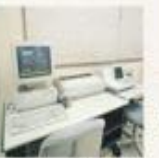
ごみ計量機 制御室
