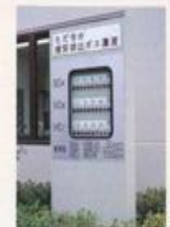
排ガス監視盤 煙突から排出される排ガスに含まれるSOx、NOx、Hclの濃度を表示します。
