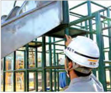
遊具の安全点検
