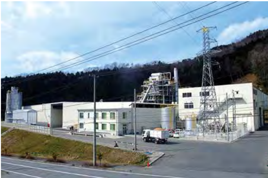
真庭バイオマス発電所 目木
