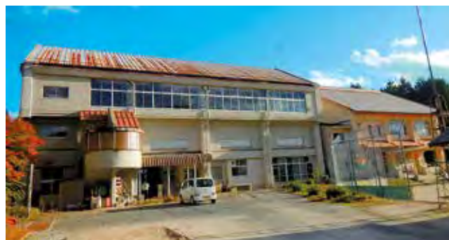
収蔵施設として改修する旧阿口小学校
