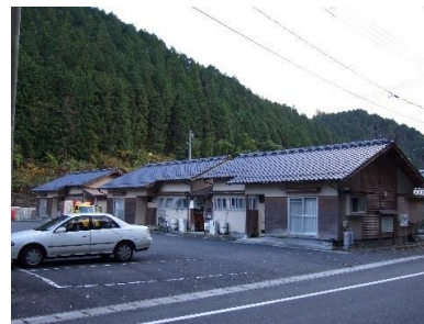
⑬若代住宅(勝山：公営住宅)
