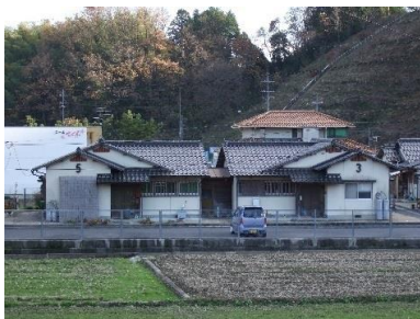
⑥草沢住宅(久世：公営住宅)
