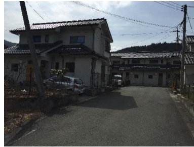
⑭第2旭住宅(梅)(美甘：公営住宅)
