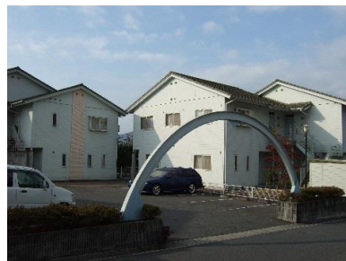
⑦寺前住宅(久世：公営住宅)
