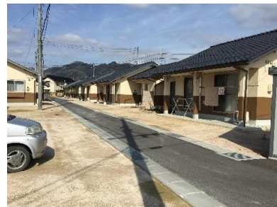
⑤高瀬住宅(久世：公営住宅)
