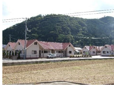
②皆部第2住宅(北房：公営住宅)
