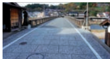
令和2年度に点検した神橋 勝山
