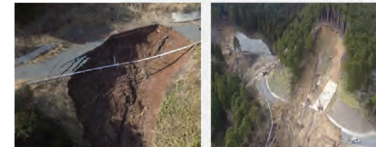
真庭市 林道 作備線 (平成30年7月)
