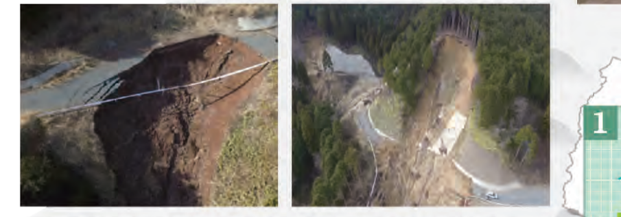
真庭市 林道 作備線 (平成30年7月)
