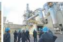
真庭バイオマス発電所 “出典：一般社団法人真庭観光局HPより”
