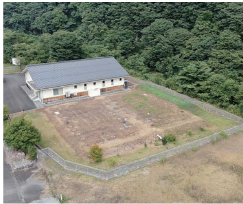
美新浄化センター
