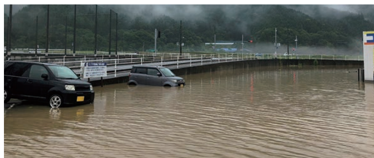
浸水の被害にあった駐車場 落合垂水
