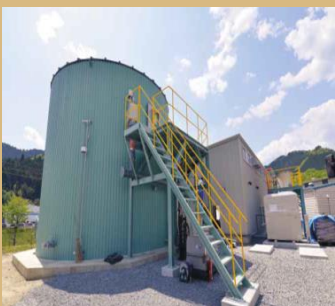
メタン発酵実証プラント
