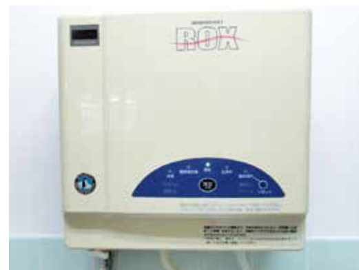
八束こども園に設置している電解水生成装置
