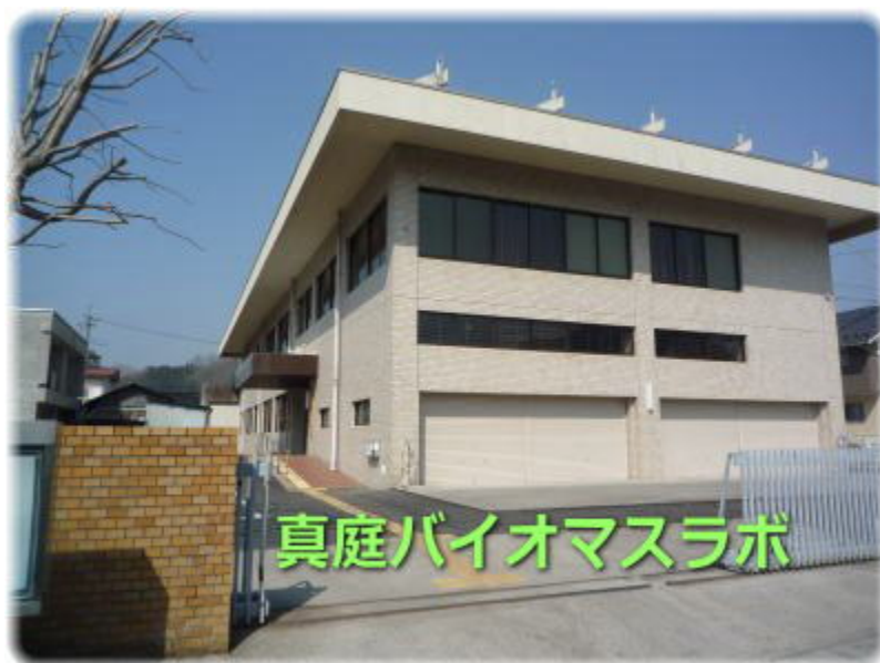
図2.1-4 真庭バイオマスラボ外観
