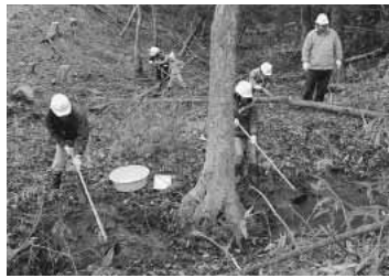
水路に溜まった草や泥を除去
