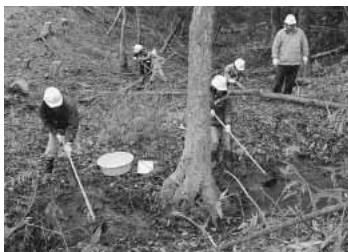
水路に溜まった草や泥を除去
