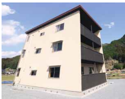
3月に完成したCLT春日住宅
