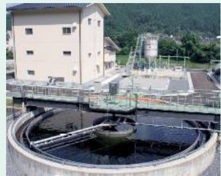
落合浄化センター
