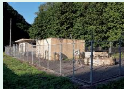
櫛西上簡易水道
