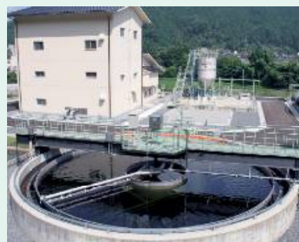
落合浄化センター
