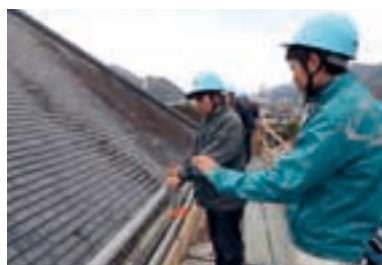
調査用の足場から屋根を見学
