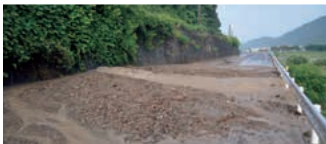
勝山地区を中心に集中豪雨が発生し、土砂崩れで通行止めとなった国道181号線 勝山～久世間（H22/7/6）
