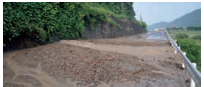
勝山地区を中心に集中豪雨が発生し、土砂崩れで通行止めとなった国道181号線 勝山～久世間（H22/7/6）
