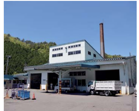
北部クリーンセンター 処理量 約3,000 t 管理運営費 約1億4,000万円
