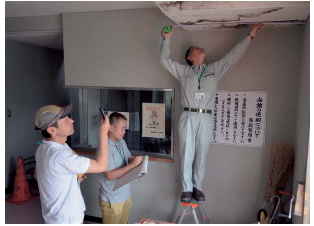
施設の腐食箇所の点検を行う市職員
