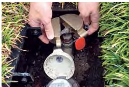
バルブを閉め、金属製の蓋を取り付けて施錠する「給水停止」
