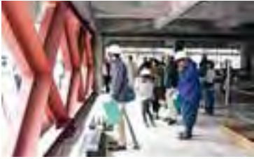
巨大な鉄骨で耐震強化
