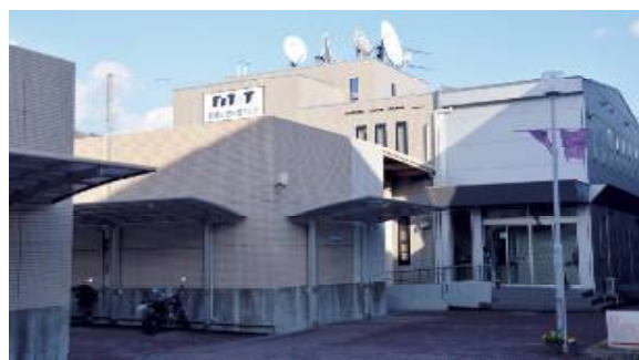
真庭市鍋屋にあるMIT局舎
