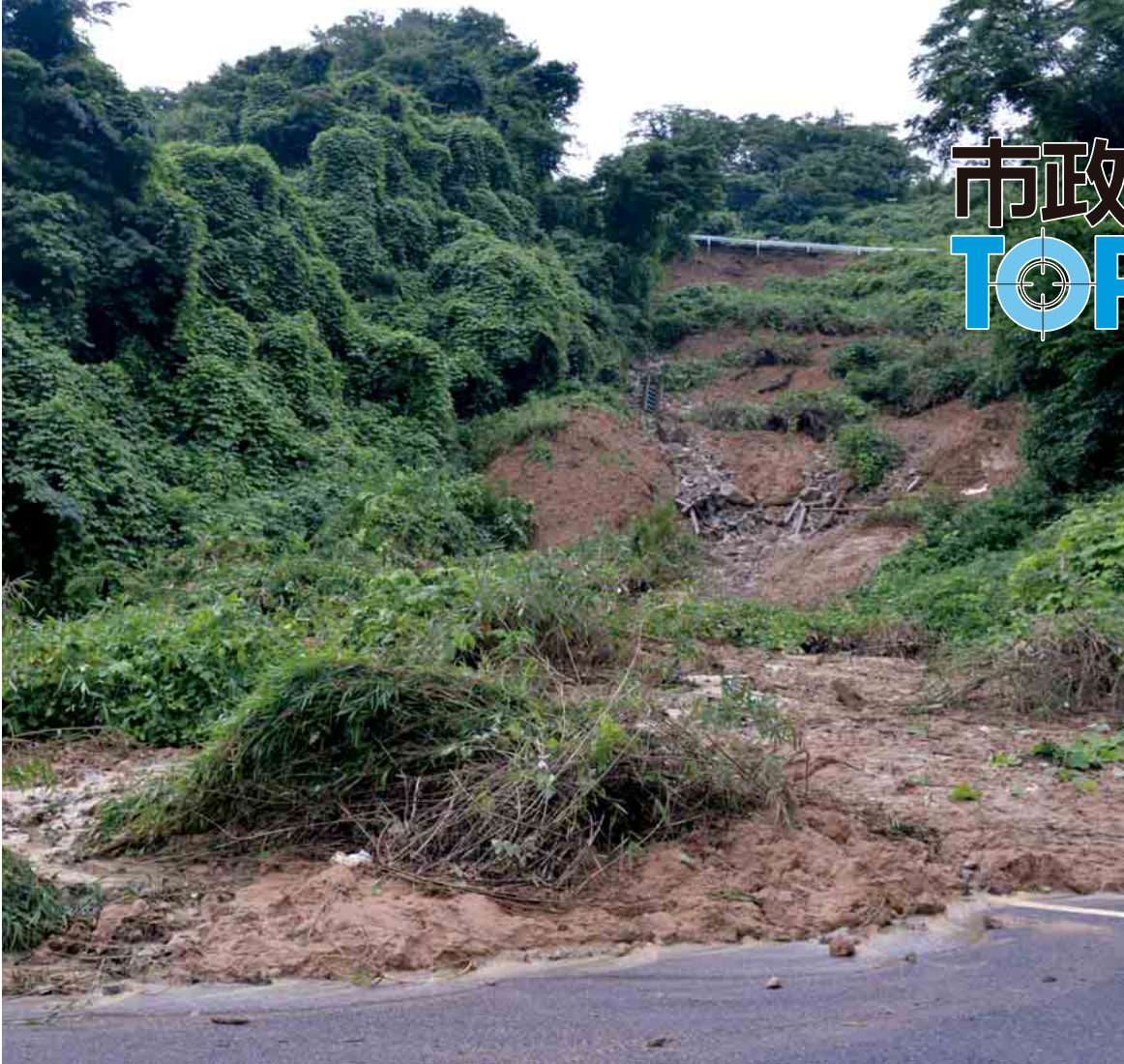
土砂の流出により通行止めになった市道神代福谷線
