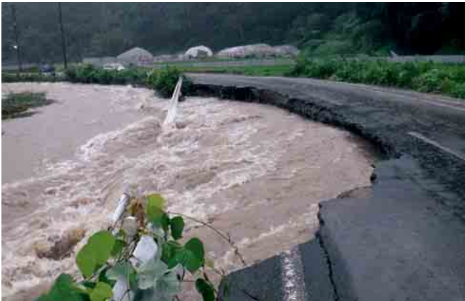
護岸が崩壊し通行止めになった県道鏡野久世線
