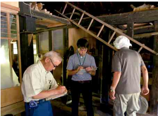
間取りだけでなく設備や軋みも確認します
