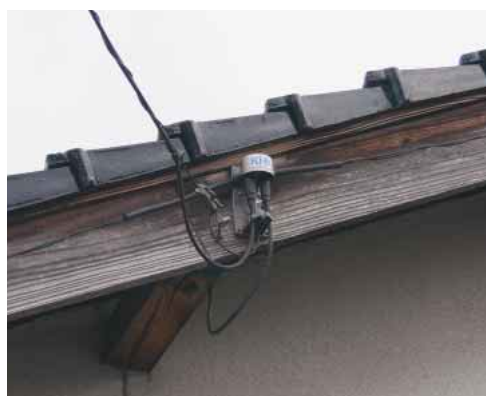
■軒先までつながった同軸線 (写真はKHKが各家庭軒先まで延ばしたもの)
