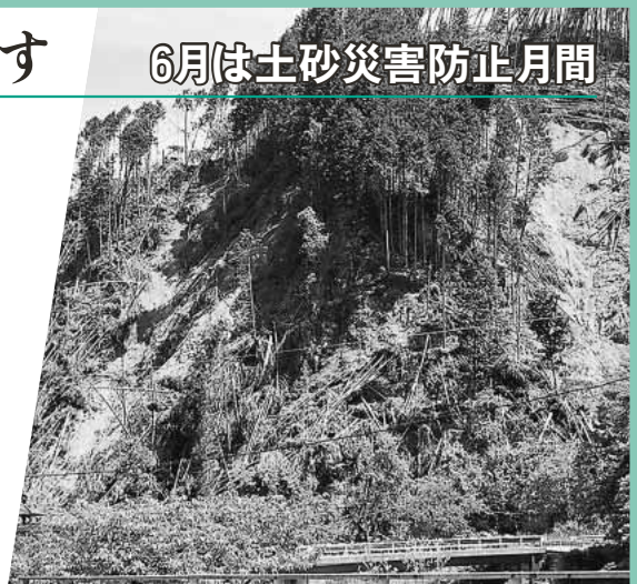
昨年の台風で山腹が崩壊した市内山林
