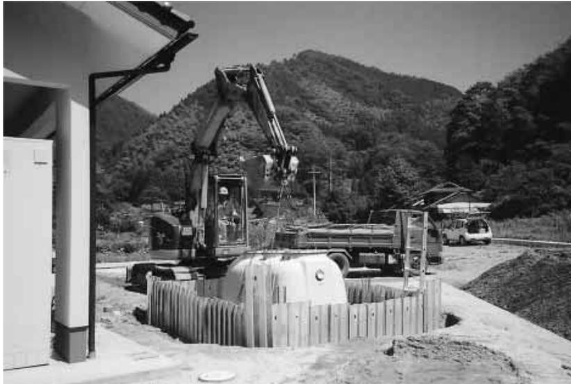
写真は7人槽設置の様子。浄化槽本体の設置工事は真庭市が行います
