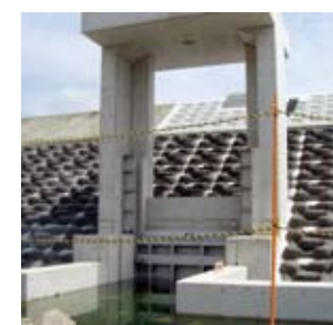
中島地区に建設中のポンプ場
