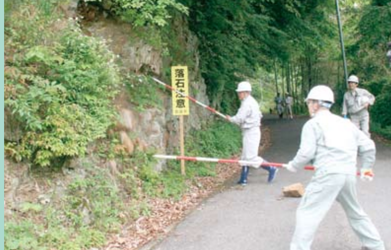
浮き石などの状態を重点的に確認（美甘地区）
