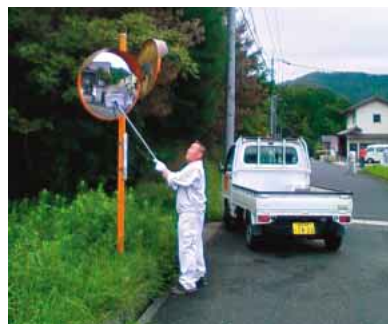
清掃作業の様子
