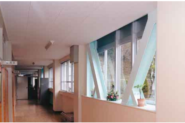
市内小・中学校の耐震補強工事が着々と進んでいます(勝山中学校)
