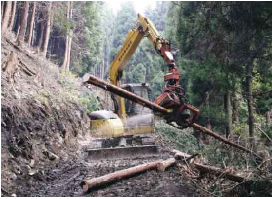
最新の機械による間伐作業
