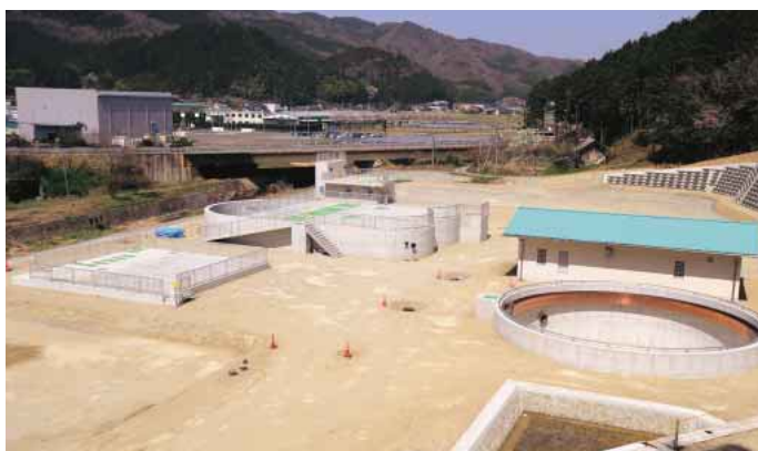
建設中の下水道処理施設（落合浄化センター）
